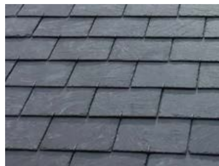
Couverture en ardoise naturelle
